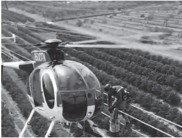
Figura 2.4 Manutenção de linhas de transmissão com o uso de helicóptero.
