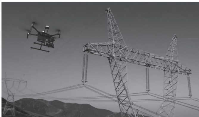
Figura 2.5 Uso de drones na manutenção de linhas de transmissão.
