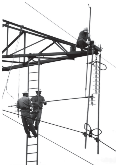
Figura 2.2 Técnica de manutenção a distância.
