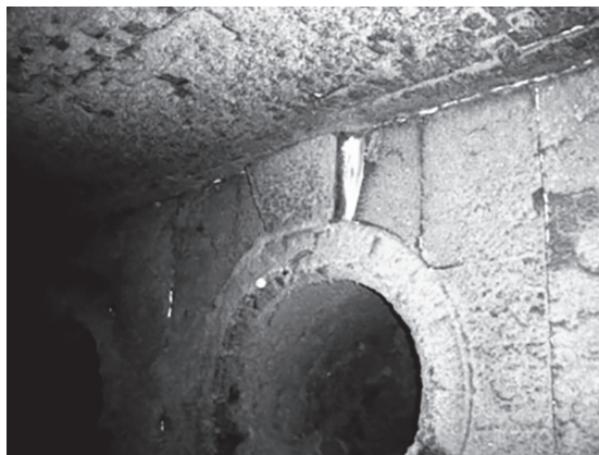
Figura 1.12 Gap entre parede e o primeiro anel.
