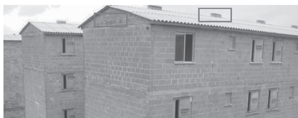
Figura 1.9 Posições dos dutos das aberturas horizontais e dos dutos verticais de ventilação da cobertura.
