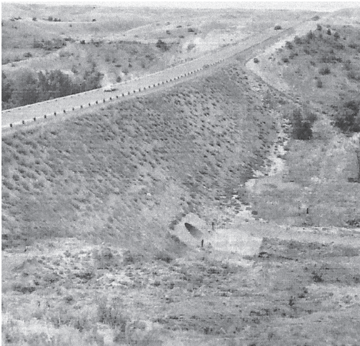
Figura 2.2 – Aterro pronto, mostrando sua drenagem inferior.
