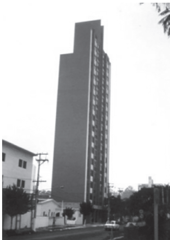
Figura 1.5 – Edifício Muriti, em São José dos Campos/SP. Foto C.A. Tauil.
