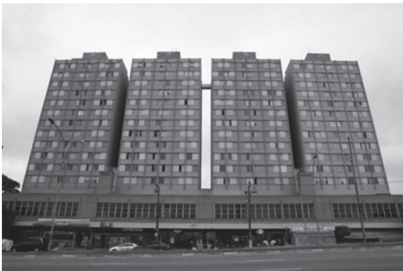
Figura 1.3 – Central Parque Lapa, 1971; doze pavimentos em AE – bloco de 19. Foto C.A. Tauil.
