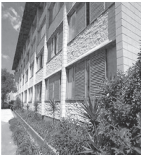
Figura 1.4 – Central Parque Lapa, 1966; quatro pavimentos em AE – bloco de 19. Foto C.A. Tauil.
