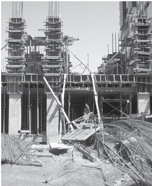
Estrutura de concreto armado (lajes, vigas e pilares) em construção. Formas e escoramento.
