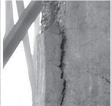
**Figura 1.17** - Spalling em pilar de concreto.
