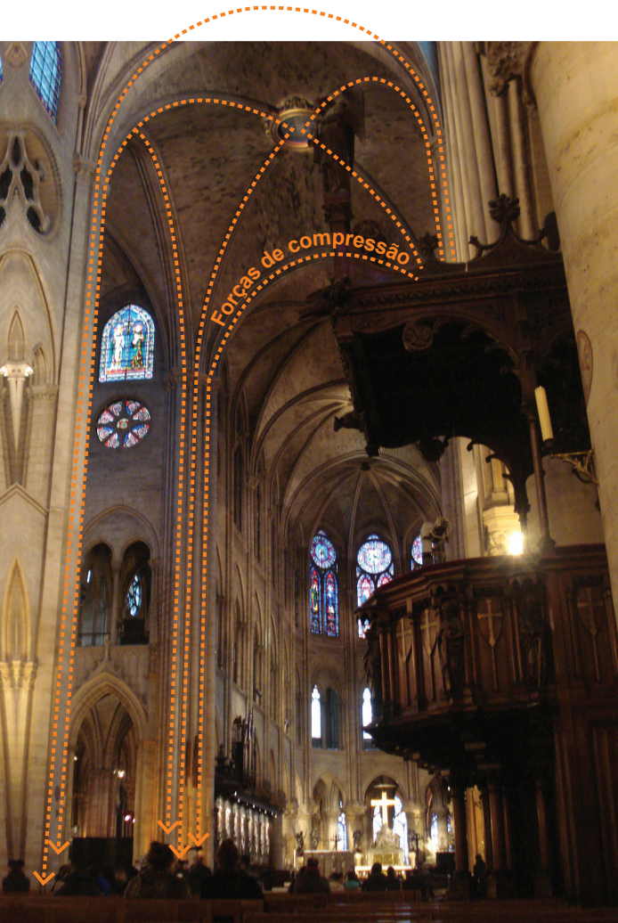
Figura 1.13 – Distribuição das forças de compressão.
