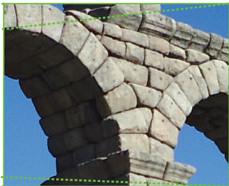
Figura 1.9 – Detalhe construtivo das reentrâncias nas pedras pertencentes ao aqueduto romano de Segóvia, Espanha.
