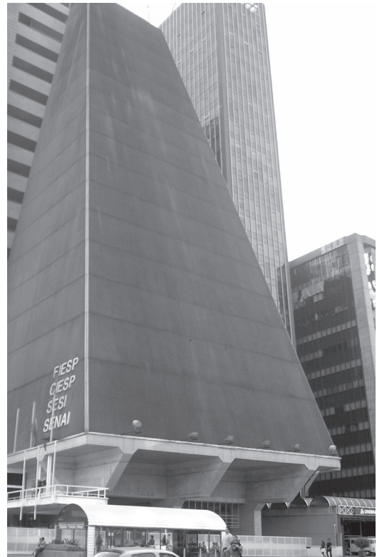
Estrutura de concreto pronta.
