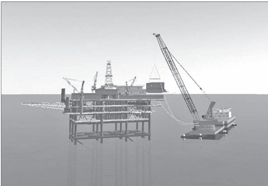
Figura 28 Simulação de retirada de módulo de acomodação (com peso de 205 tf) de plataforma fixa no Campo de Cherne (Bacia de Campos) por guindaste Clyde (capacidade de içamento de até 1.000 tf) de balsa guindaste lançamento (BGL). Na simulação numérica o alcance horizontal foi de 42,7 m e a tração de içamento no cabo foi de 271,4 tf com ondas de altura 1 m, sem marulho.
