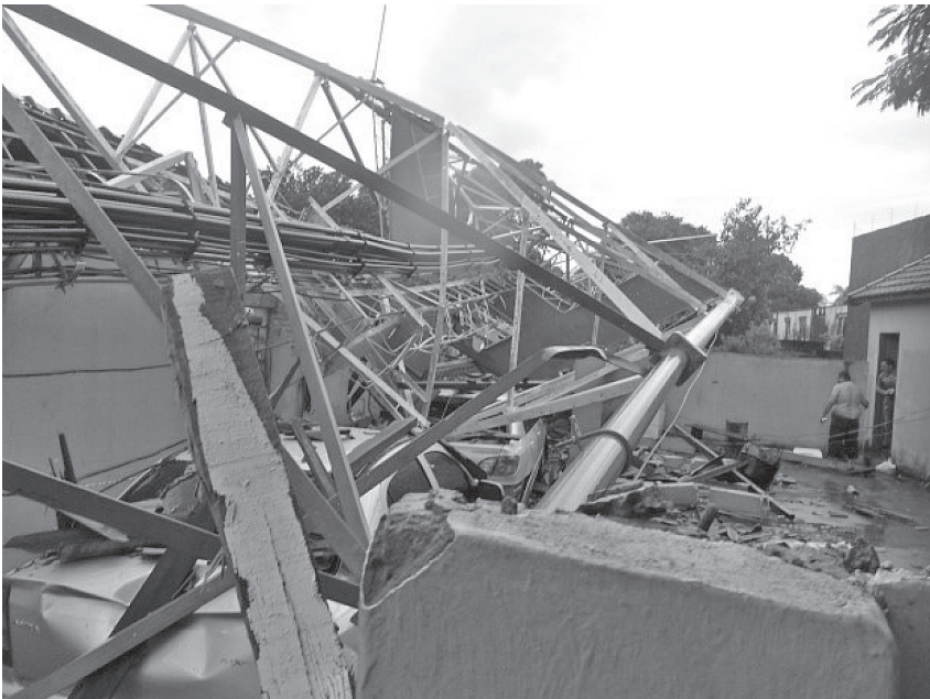
Figura 1.1 – Torre de telecomunicações que ruiu sob o carregamento de vento. Fonte: Zanilda Alves da Silva Lionakis/arquivo pessoal.
