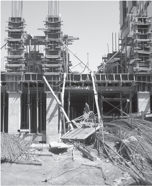
Estrutura de concreto armado (lajes, vigas e pilares) em construção. Fôrmas e escoramento.
