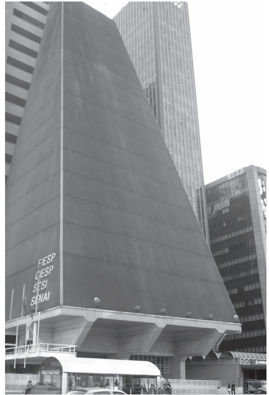
Estrutura de concreto pronta.
