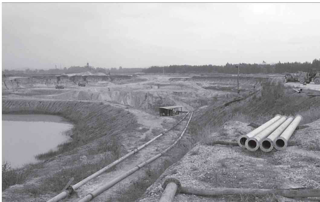
FIGURA 1.9 – Foto que permite avaliar o passivo ambiental deixado pela mineração de areia na cidade de Jacareí, SP, que está sendo tratado.
