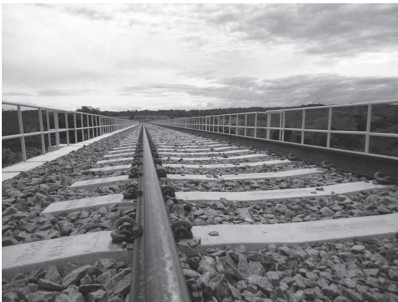
**Figura 1.5** – Ferrovia Norte-Sul. As obras da Ferrovia Norte-Sul consumiram mais de 2,5 milhões de dormentes de concreto, 170 mil toneladas de aço para os trilhos e 3,5 milhões de m<sup>3</sup> de brita para o lastro.
