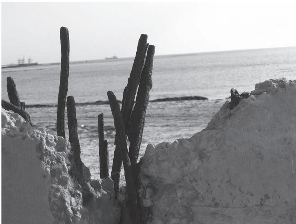
**Figura 2.15** – Concreto armado com barras de aço corroídas.
