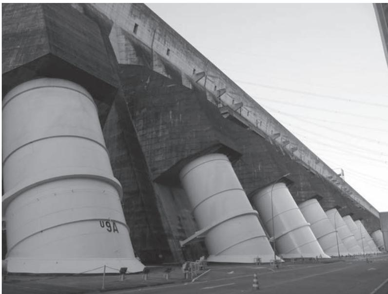
**Figura 1.4** – Itaipu Binacional. Em um único dia, no pico da obra, foram lançados cerca de 7 mil m<sup>3</sup> de concreto, o equivalente ao volume de 900 caminhões-betoneira. O total de concreto consumido superou 12 milhões de m<sup>3</sup>.
