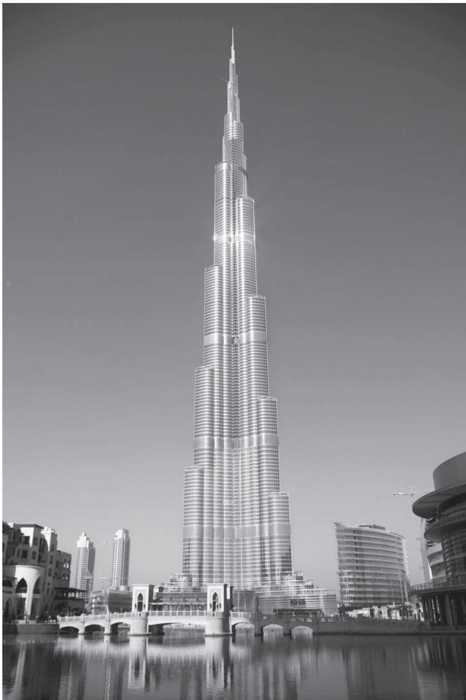
**Figura 1.3** – Burj Khalifa, em Dubai. Ao longo de seus 163 andares (828 m), o Burj Khalifa consumiu 330 mil m<sup>3</sup> de concreto, 55 mil toneladas de aço e 28 mil painéis de vidro.
