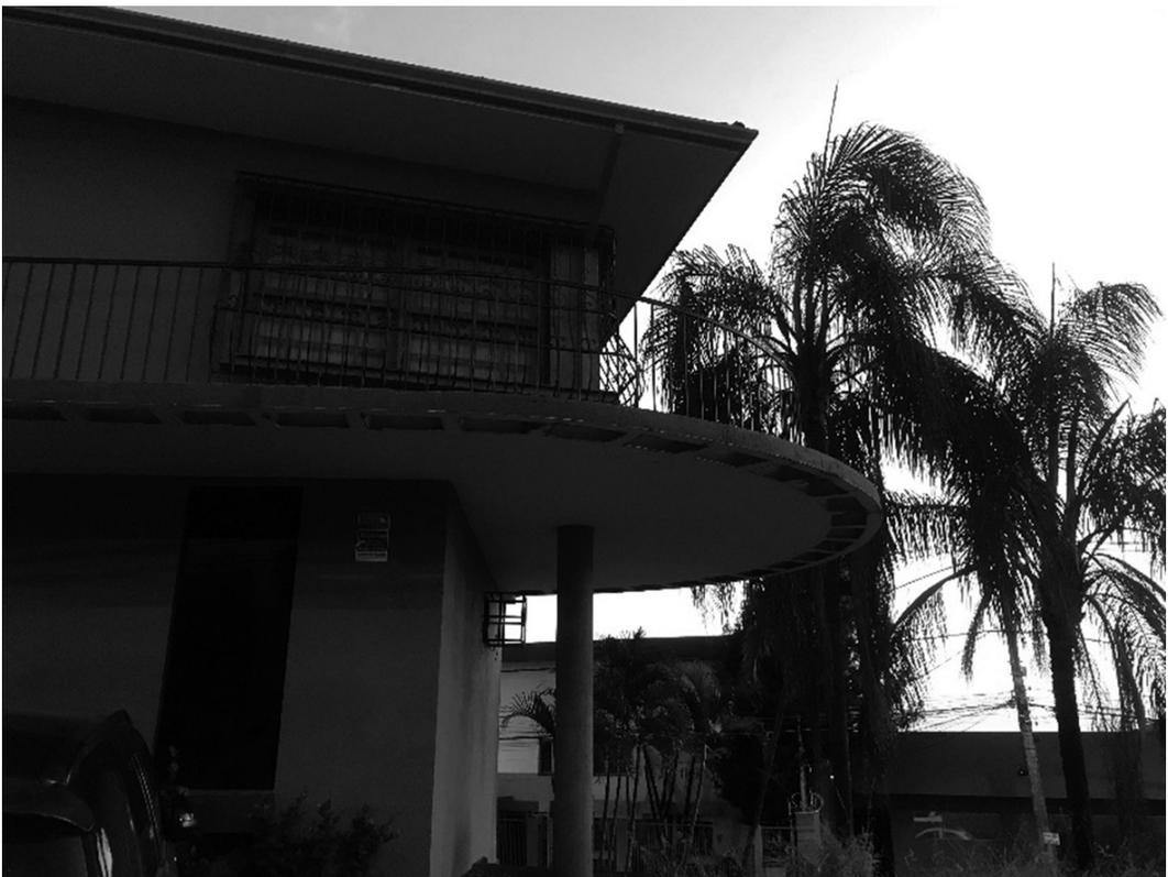
Laje em balanço com guarda-corpo (também chamado de parapeito); nesse caso a área é denominada de sacada. O guarda-corpo é um dispositivo de segurança, não da estrutura, mas sim dos usuários da laje
