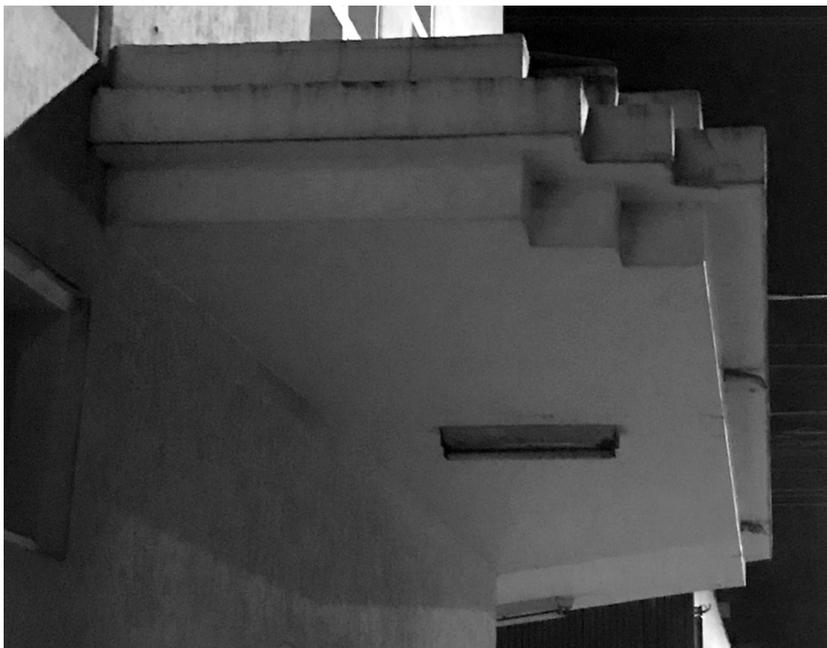
Fotografia de laje em balanço, denominada anteriormente por laje marquise. Como detalhe podemos citar os buzínates (drenos).
