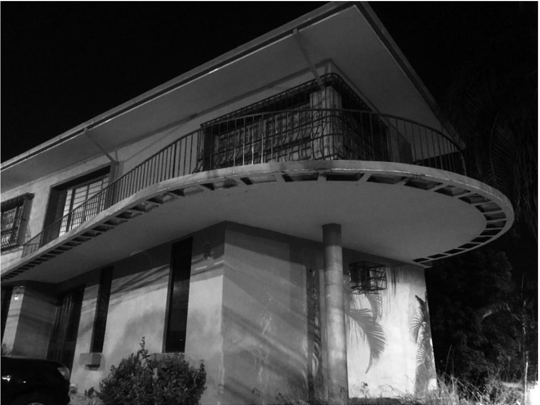
Visão da sacada por um novo ângulo; notem que o pilar ou coluna existente está situado diretamente abaixo da construção existente acima da laje, não significando necessariamente que esteja sustentando a laje em balanço, mas que a estrutura superior do sobrado não está alinhada com a inferior
