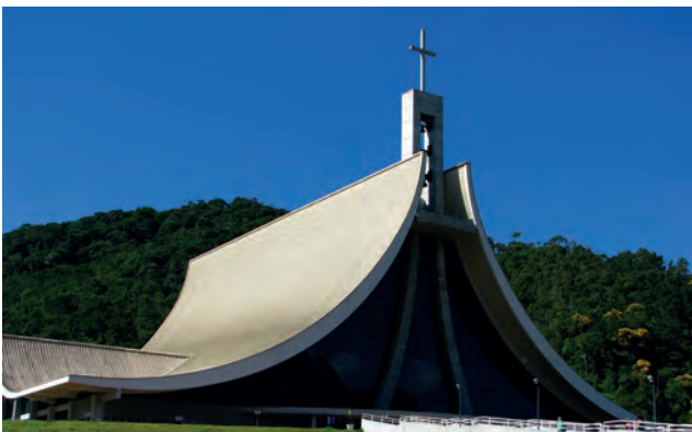
Fotografia 5 Santuário Madre Paulina (Nova Trento/SC, 2006). Telhado sustentado por grandes vigas em concreto protendido, com vão de aproximadamente 60 m, permitindo a inexistência de pilares na área de circulação de público do Santuário. Projeto estrutural de OA Engenharia Especial e M. Schmid Engenharia Estrutural. Fotografia adaptada de Vinicius Lannes Duer...; Wikimedia Commons, CC-BY-AS-3.0.
