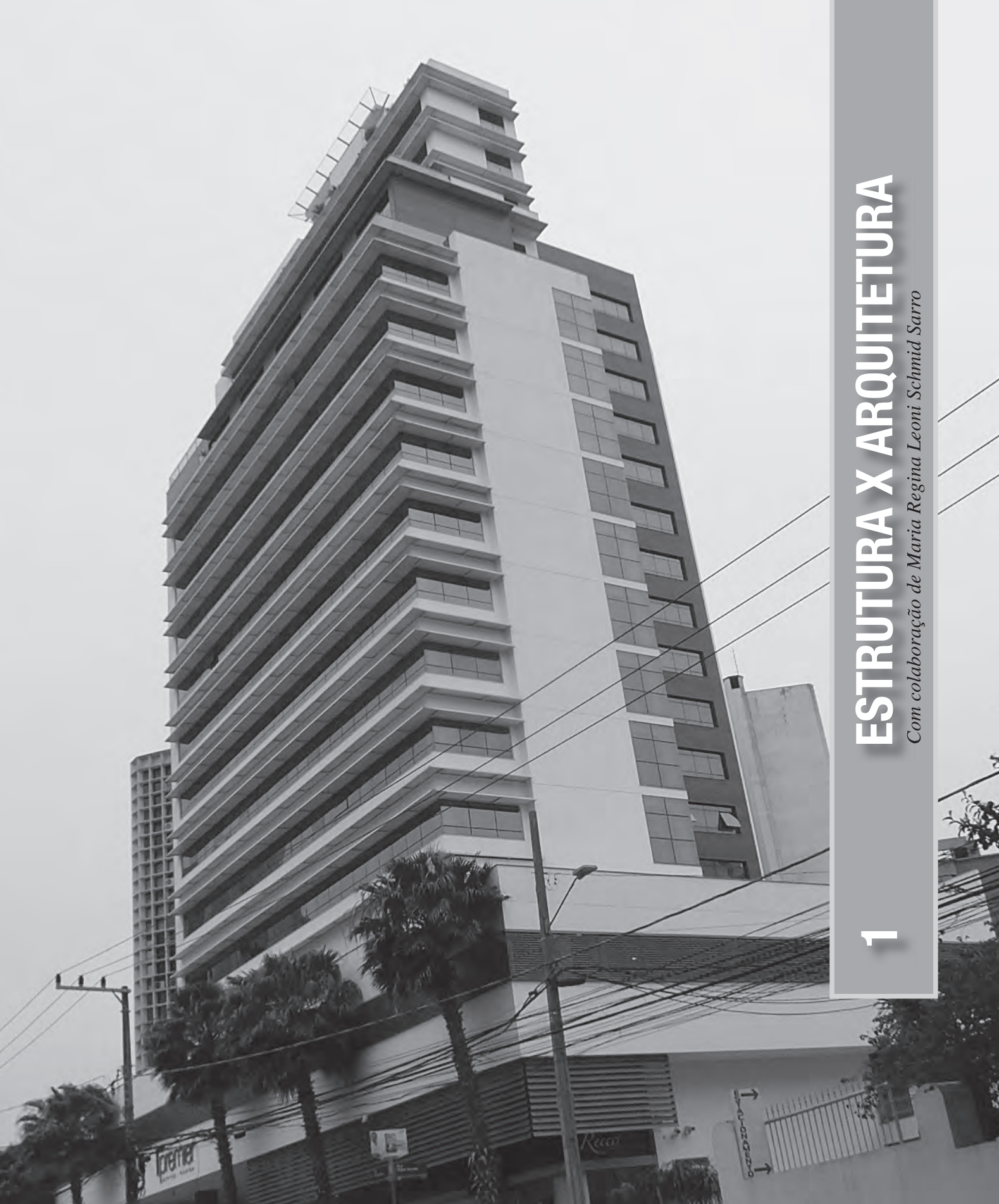
Fotografia 1 Edifício Premier (Florianópolis/SC, 2010). Edifício residencial com vigas de transição profundas. Projeto estrutural de Stabile Estruturas e M. Schmid Engenharia Estrutural. Protensão: Sistema Rudloff. Fotografia do arq. Tuing Ching Chang.
