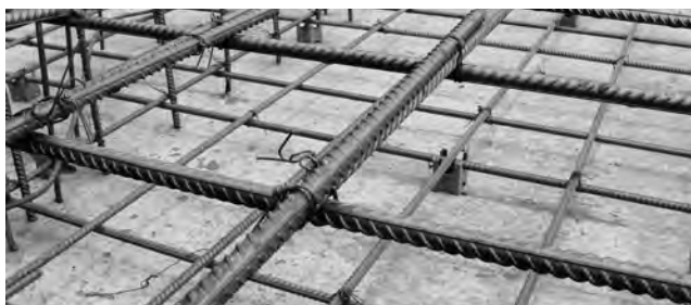
Fotografia 3 Montagem de armadura para laje de concreto armado, já amarrada e afastada da forma. Fotografia adaptada de Koletvinov, adquirida de https://br.depositphotos.com/ .
