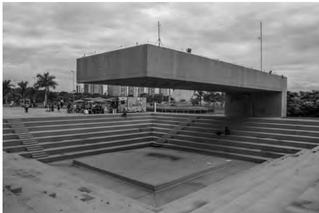
Fotografia 4 Anfiteatro do Parque Villa-Lobos (São Paulo/SP, 2009). Pórtico em concreto protendido, com balanço de 24 m. Projeto arquitetônico do arq. Decio Tozzi; projeto estrutural do eng. Ugo Tedeschi. Fotografia de Mike Peel ( www.mikepeel.net ), Wikimedia Commons, CC BY-SA 4.0.
