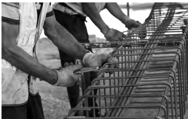
Fotografia 2 Montagem de armadura para viga de concreto armado, em processo de amarração de barras. Fotografia adaptada de Budabar, adquirida de https://br.depositphotos.com/ .
