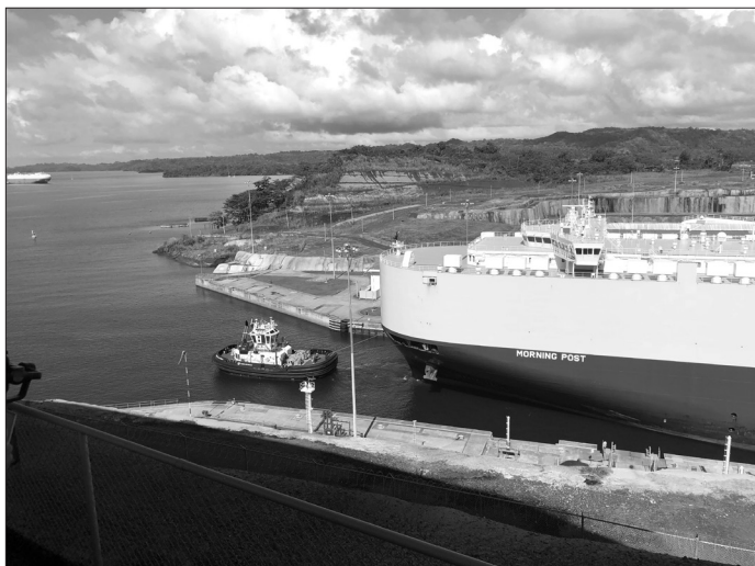
Figura 24.104 Eclusas de Água Clara: passagem da proa da embarcação pelo emboque de montante da eclusa superior para o Lago Gatún.
