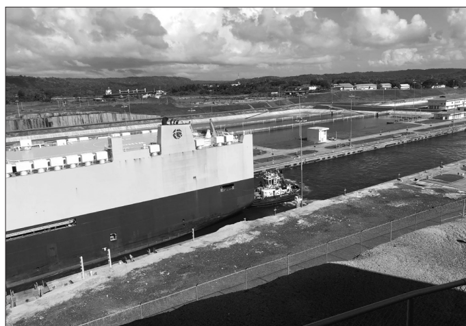
Figura 24.107 Eclusas de Água Clara: continuação da saída do navio, observando-se, em segundo plano à esquerda, uma embarcação mercante descendo as Eclusas de Gatún.
