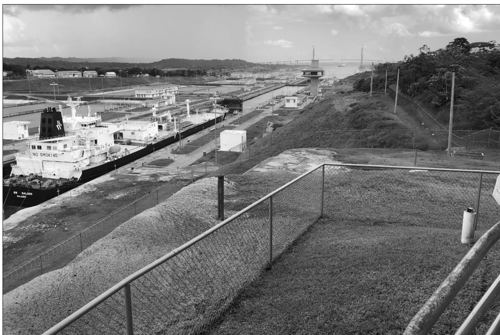
Figura 24.124 Eclusas de Água Clara: início do esvaziamento da câmara superior, notando-se a turbulência na segunda câmara de reuso pelo desvio de água para o aqueduto dela.
