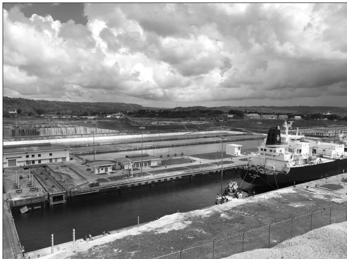
Figura 24.124 Eclusas de Água Clara: início do esvaziamento da câmara superior, notando-se a turbulência na segunda câmara de reuso pelo desvio de água para o aqueduto dela.
