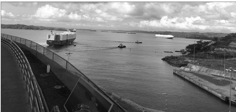
Figura 24.112 Eclusas de Água Clara: rebocadores retornando à base para aguardar a próxima faina.
