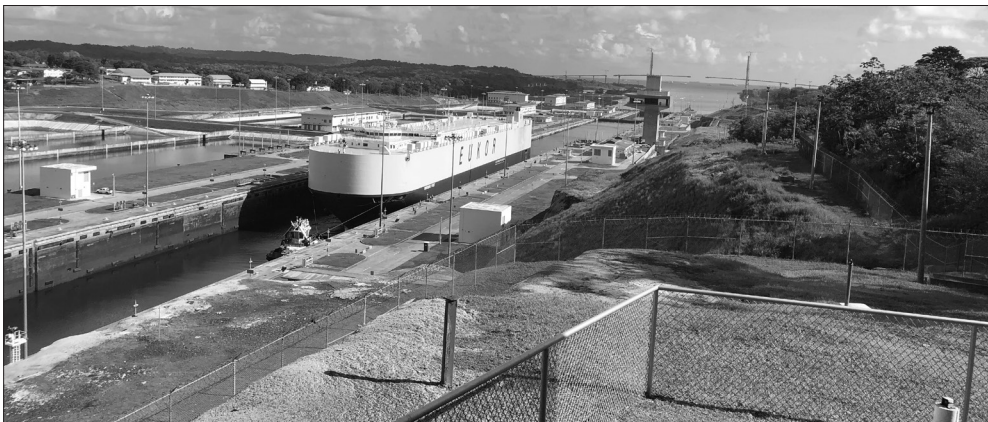
Figura 24.97 Eclusas de Água Clara: uma vez completamente abertas as portas intermediárias, o rebocador traz a embarcação para a câmara superior em que é amarrada temporariamente nos cabeços laterais.
