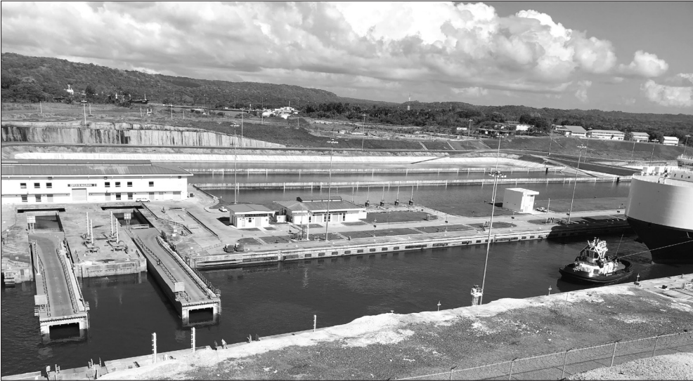
Figura 24.101 Eclusas de Água Clara: a operação de abertura das portas demanda 5 minutos.
