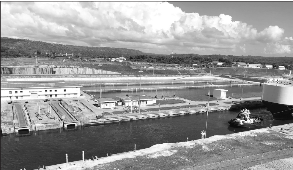
Figura 24.102 Eclusas de Água Clara: com as portas de montante da câmara superior totalmente abertas, a embarcação é desamarrada e os dois rebocadores de apoio podem conduzi-la ao Lago Gatún.
