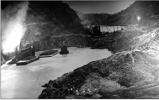
Figuras 24.49 e 24.50 Aspectos das obras conduzidas pelos norte-americanos no Corte Culebra entre 1907 e 1913 com escavadeiras terrestres e de alcatruzes no lençol de água.
