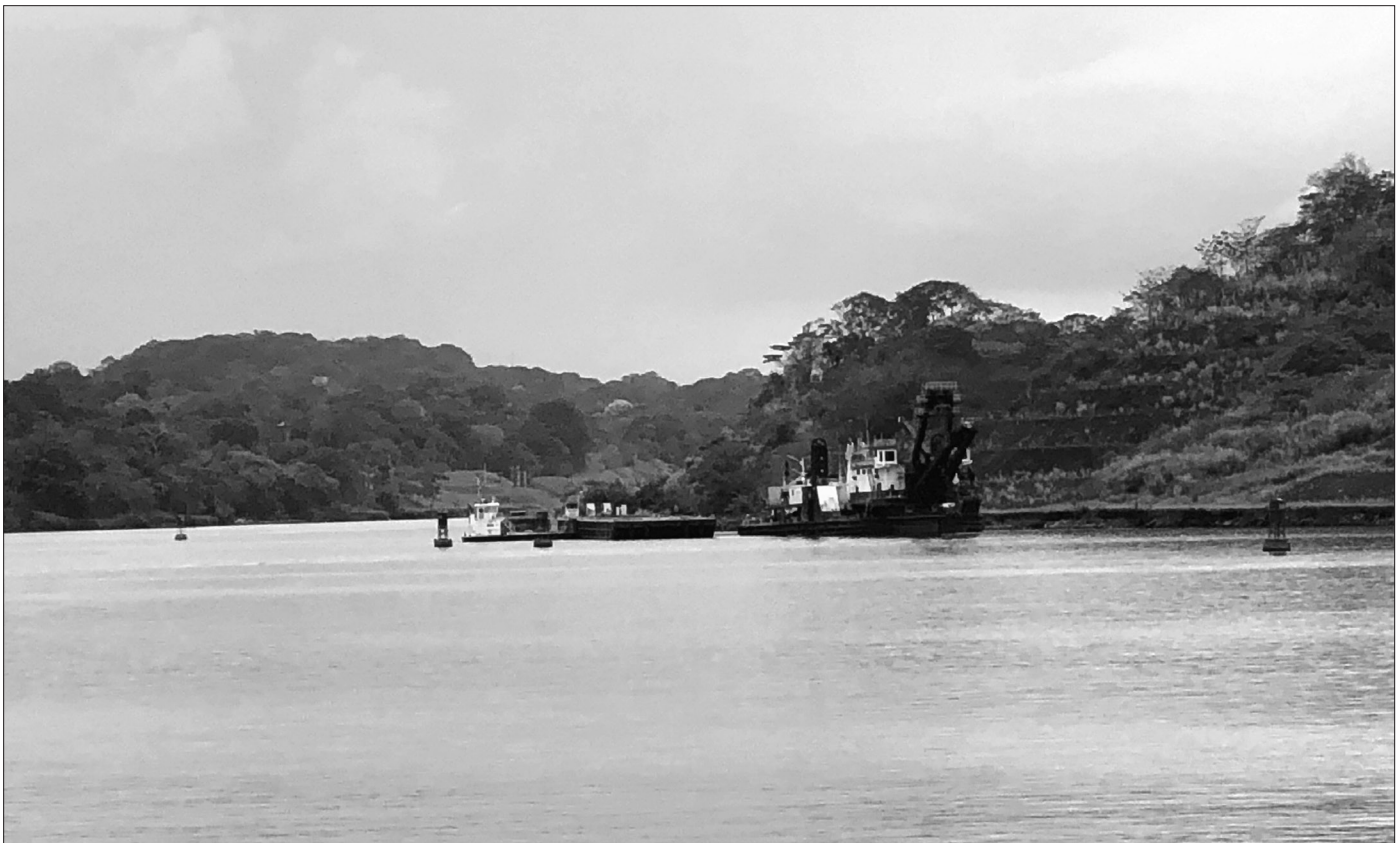
Figura 24.83 Serviços de dragagem de manutenção rotineiros no Corte Culebra.
