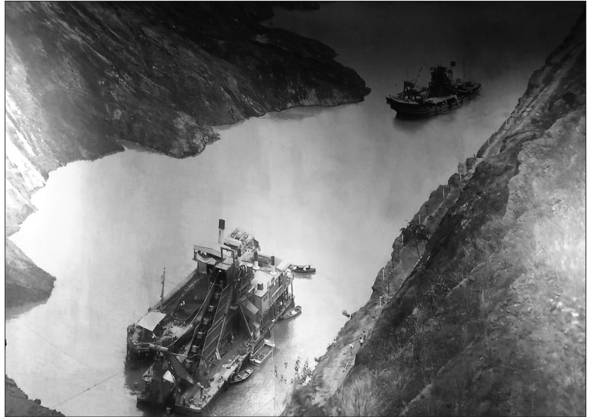
Figuras 24.49 e 24.50 Aspectos das obras conduzidas pelos norte-americanos no Corte Culebra entre 1907 e 1913 com escavadeiras terrestres e de alcatruzes no lençol de água.
