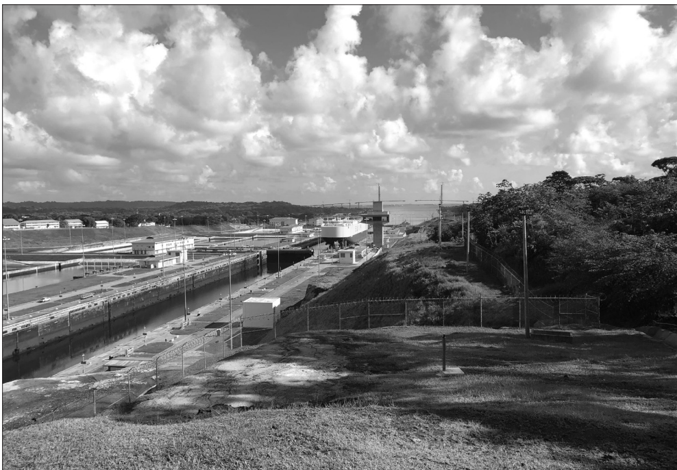
Figura 24.96 Eclusas de Água Clara: embarcação transportadora de veículos esperando a passagem da câmara intermediária para a superior, notando-se a abertura das portas com os níveis da câmara superior equalizados com os da câmara intermediária. Na câmara, com a embarcação, ficam dois rebocadores de cabo passado, um à vante e outro à ré.
