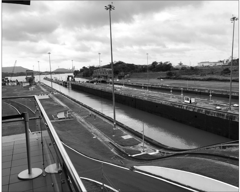
Figura 24.60 Eclusas de Miraflores: vista da câmara inferior esgotada em primeiro plano.
