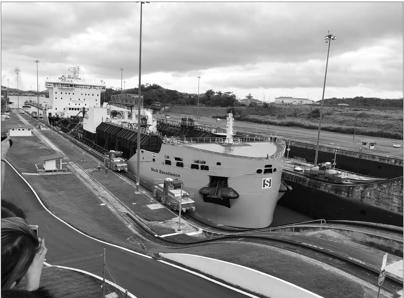
Figura 24.63 Eclusas de Miraflores: frenagem do navio na câmara inferior para fechamento das portas de jusante da câmara inferior.
