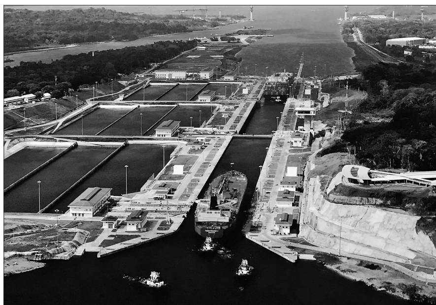
Figura 24.90 Vista aérea das eclusas e dos sistemas de reuso de água de Água Clara, do terceiro jogo de eclusas (primeiro plano à esquerda), observando-se um navio-tanque e um navio contêiner, seguindo do Lago Gatún rumo ao Mar do Caribe. Notar, na parte inferior central, os três rebocadores que conduziram o navio para fazê-lo adentrar na câmara superior e, dos quais, somente um de cabo passado irá acompanhar o navio na eclusagem. Em segundo plano, à esquerda, identifica-se o canal de acesso às eclusas centenárias de Gatún e, ao fundo da imagem, as obras da terceira ponte fixa sobre o Canal do Panamá.
