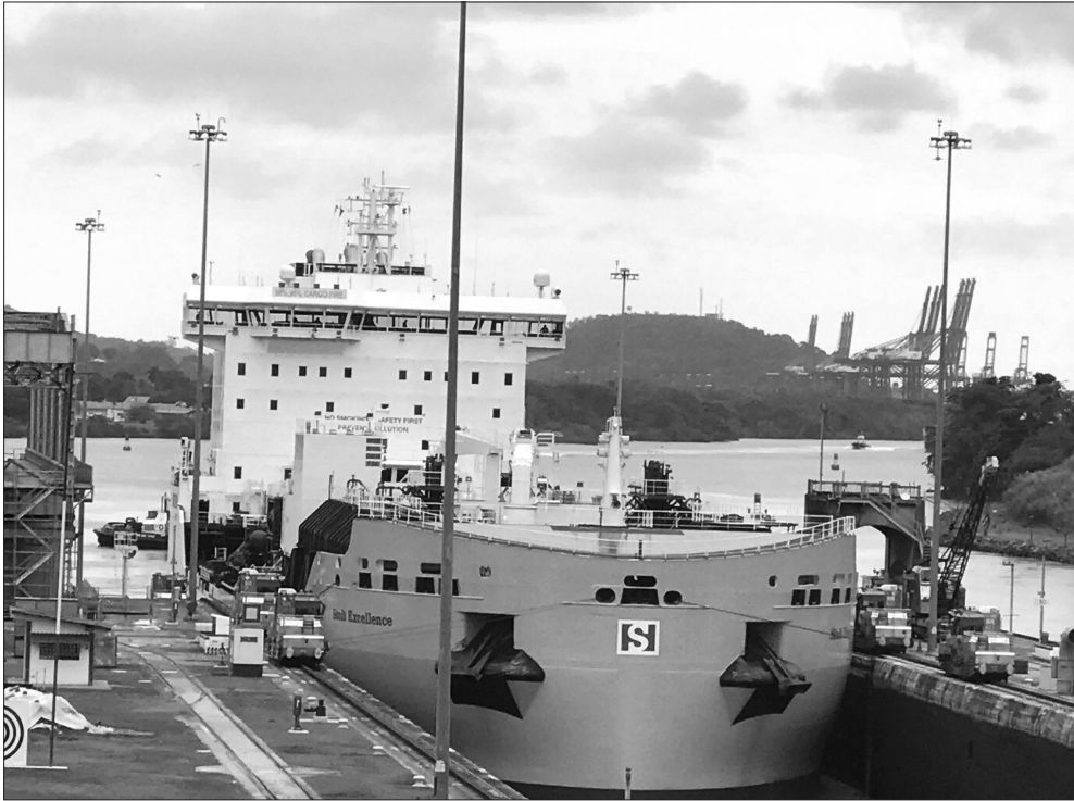
Figura 24.62 Eclusas de Miraflores: entrada de navio tanque na câmara inferior rebocado por seis locomotoras.
