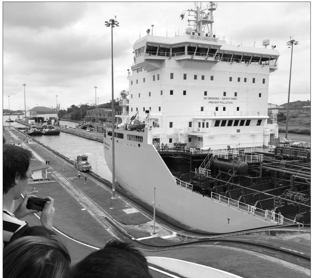
Figura 24.65 Eclusas de Miraflores: nivelamento da linha d'água das duas câmaras, abertura das portas de montante da câmara inferior e deslocamento do navio para a câmara superior.
