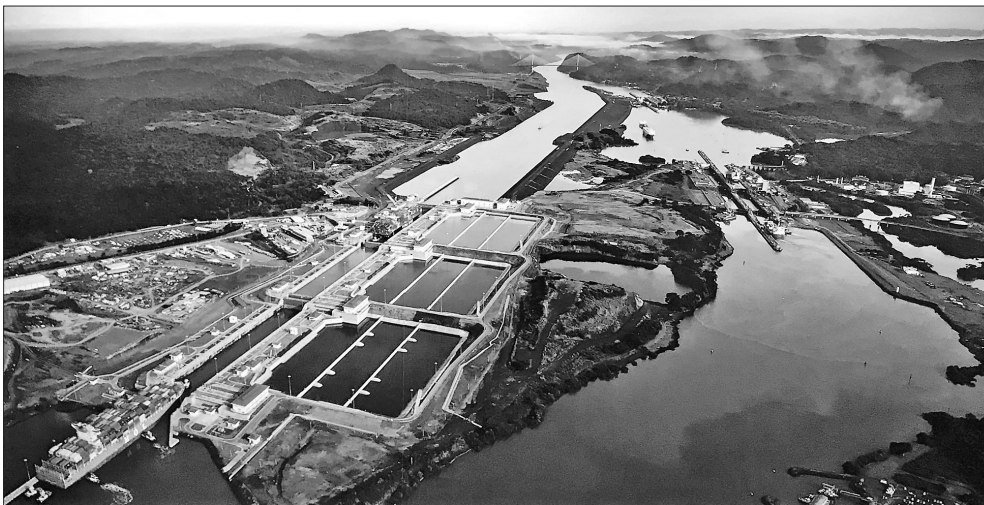
Figura 24.89 Vista aérea das eclusas e dos sistemas de reuso de água de Cocolí, do terceiro jogo de eclusas (primeiro plano à esquerda), observando-se dois navios contêineres seguindo rumo à travessia da ponte Centenário e Corte Culebra. Notar, no canto inferior esquerdo, a faina de cinco rebocadores para fazer adentrar na câmara inferior do navio contêiner Neopanamax. Em segundo plano, à direita, identificam-se as eclusas centenárias, com as quatro câmaras das Eclusas de Miraflores, o lago homônimo, e, ao fundo, as duas câmaras das Eclusas de Pedro Miguel.
