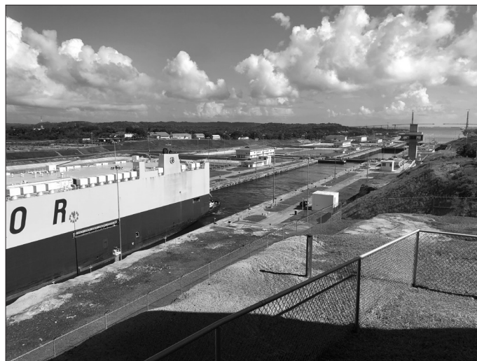
Figura 24.105 Eclusas de Água Clara: rebocador de ré atuando como empurrador.
