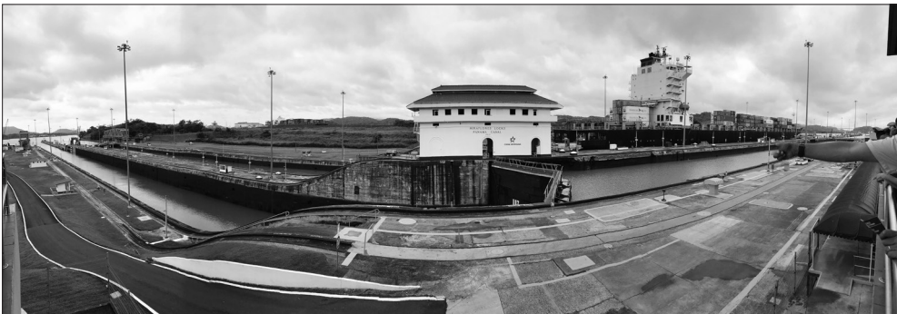
Figura 24.58 Eclusas de Miraflores: em primeiro plano, vista panorâmica com a câmara inferior esgotada de portas abertas e a superior com um conjunto de portas de busco fechado sem embarcações; em segundo plano, pode-se observar navio contêiner na câmara superior, e, ao fundo superior esquerdo, um navio contêiner Neopanamax sendo elevado na Eclusa de Cocolí.
