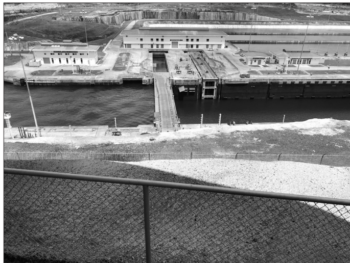
Figura 24.125 Eclusas de Água Clara: câmara superior com nível d'água rebaixando.
